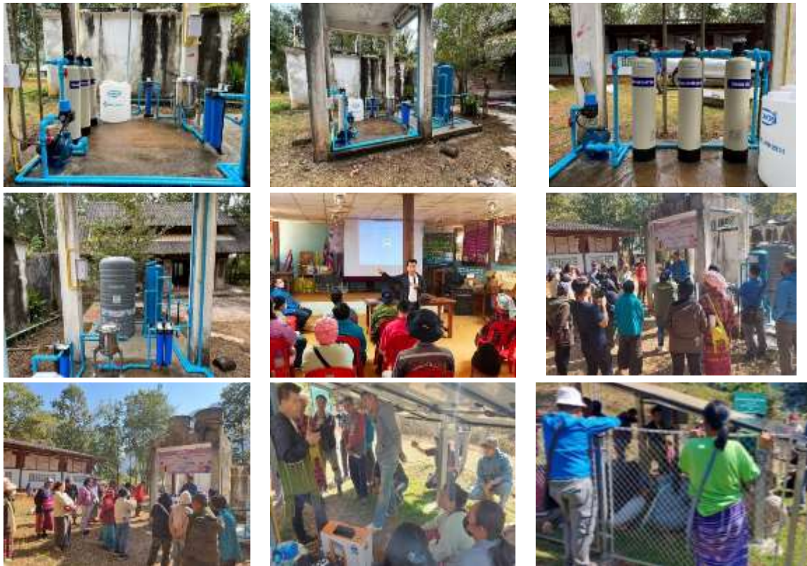
รูปภาพ : การติดตั้งระบบกรองน้ำดื่มสะอาด
